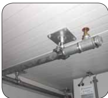
Sonderausstattung Sprinklerrohrnetz
