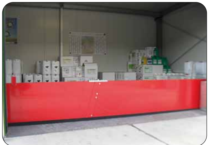
Löschwasserrückhaltung mit dreh-klappbarer Barriere
