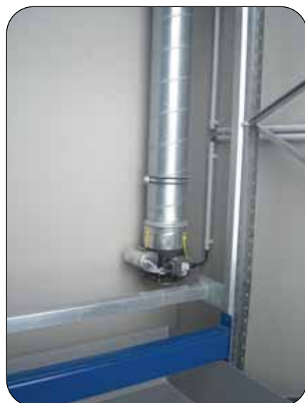
Ex-Abluftanlage inkl. brandgeschützter Lüftungselemente
