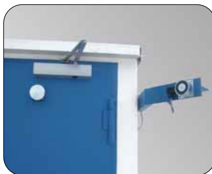
Türfeststellanlage mit allgemeiner bauaufsichtlicher Zulassung
