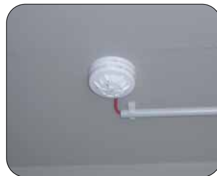
Wärmemelder zur Ansteuerung der Türfeststellanlage
