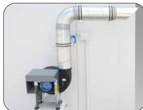
Ex-geschützter Abluftventilator inkl. Abluftüberwachung
