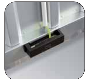
Potentialausgleichschiene, Artikel-Nr. H63-9031-A
