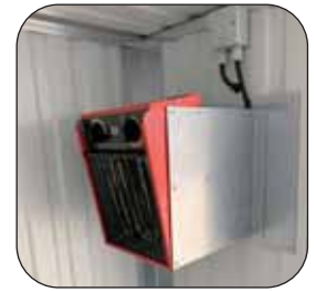
Umluftheizung 2 kW, nicht ex-geschützt, Artikel-Nr. H63-9020-A
