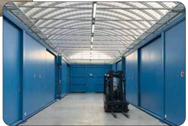
◆ Gangüberdachung mit Dachlichtband ◆ Gangbeleuchtung
