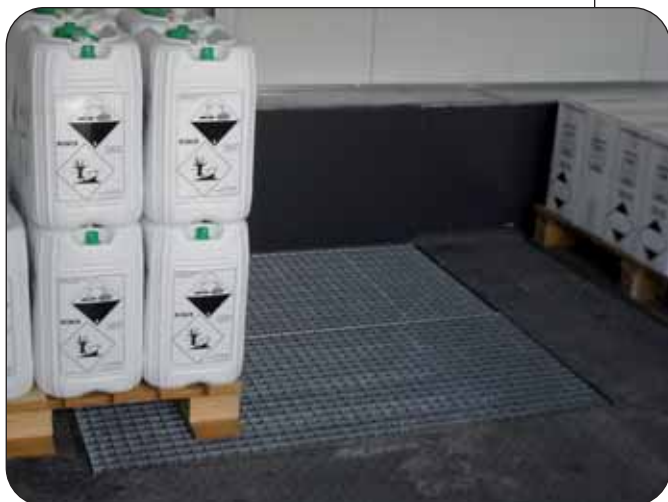
Geeignete Lagerfläche mit Pumpensumpf
