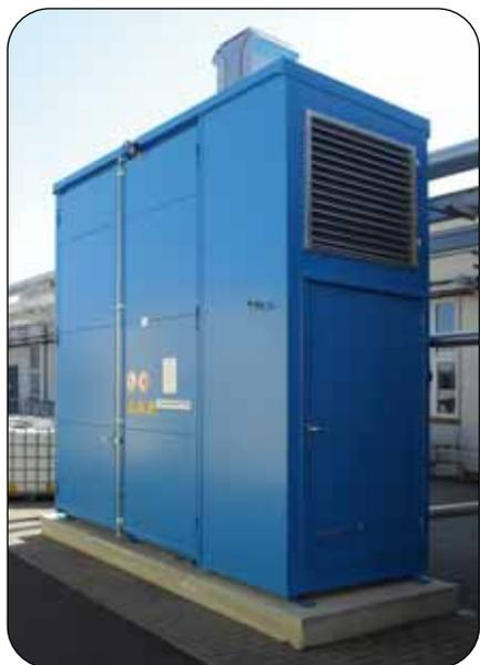
Thermo-Wasserschutz-Fachcontainer mit separatem Technikraum
