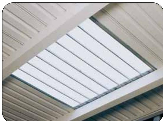
In Gefahrstofflagern ist für eine ausreichende Beleuchtung zu sorgen (s. ASR A3.4). Hierfür ist nicht immer zwingend eine elektrische Beleuchtung notwendig. Mittels optionalem Dachlichtband können in der hellen Jahreszeit das Tageslicht oder natürlich auch Lichtquellen außerhalb des Lagerhauses zur Ausleuchtung genutzt werden.
