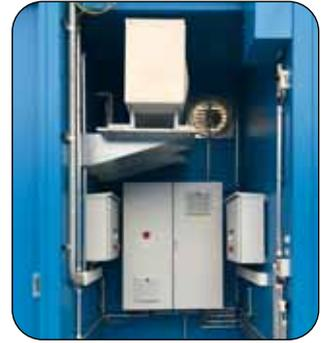
◆ Zentrale Steuereinheit (Schaltschrank, E-Unterverteilung, Kühlaggregat)
