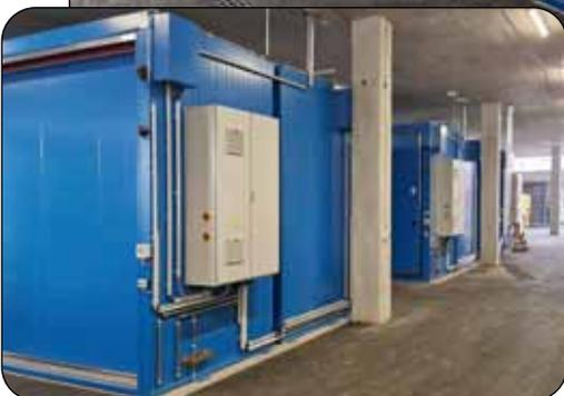
◆ Brandschutzcontainer wurden im Gebäudekomplex (Erdgeschoss) integriert
