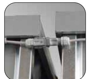
Optionale Steckverbindung bei SLH Kombination
