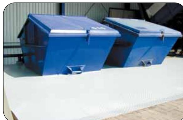
Für Verpackungen mit  $\leq 20$  L oder restentleerte Gebinde ist kein Rückhaltevolumen erforderlich. Eine flüssigkeitsundurchlässige Fläche und eine schnelle Schadensbeseitigung mit einfachen betrieblichen Mitteln müssen vorhanden sein.
