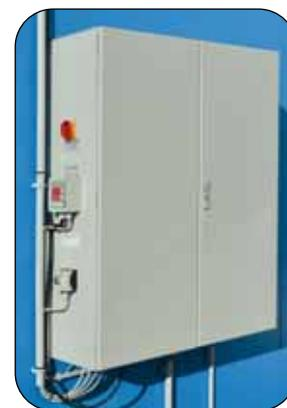
Schaltschrank mit zentraler Steuerung und Bedienelementen
