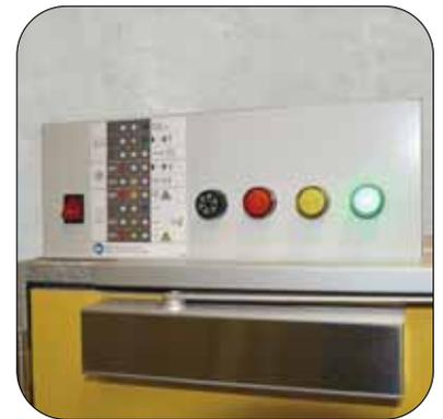
Steuereinheit mit Branddetektion
