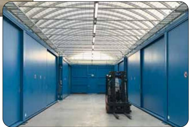
◆ Gangüberdachung mit Dachlichtband
