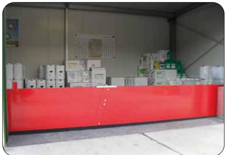
**Löschwasserrückhaltung mit dreh-klappbarer Barriere**
