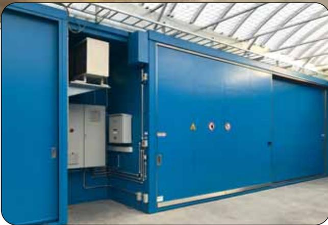
◆ Separater Brandabschnitt mit integriertem Brandschutzcontainer
