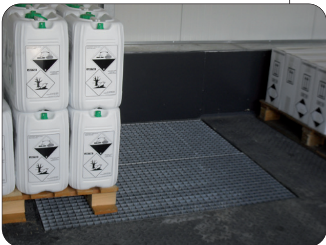
Geeignete Lagerfläche mit Pumpensumpf
