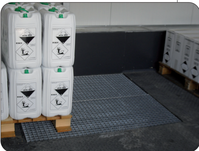
Geeignete Lagerfläche mit Pumpensumpf
