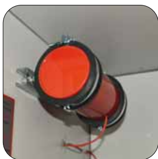
Aerosol-Löschgenerator
