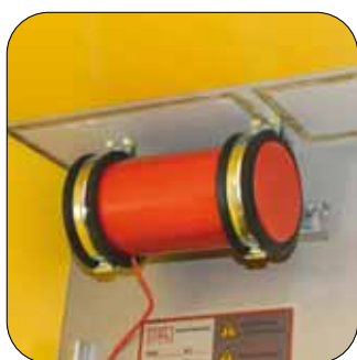
Aerosol-Löschgenerator
