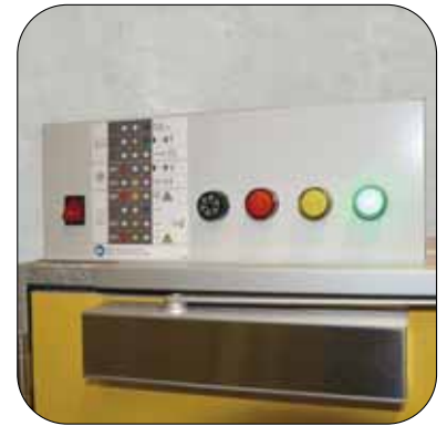
Steuereinheit mit Branddetektion
