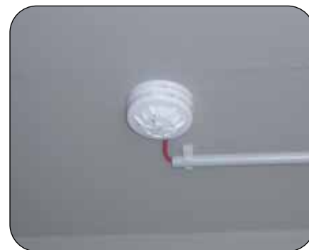
Wärmemelder zur Ansteuerung der Türfeststallanlage
