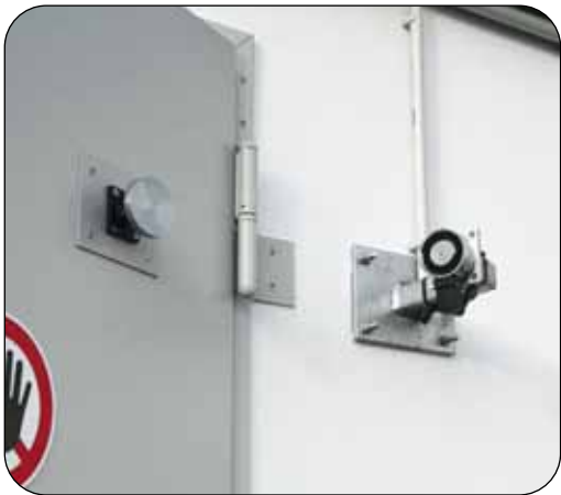
Türfeststellanlage mit allgemeiner bauaufsichtlicher Zulassung
