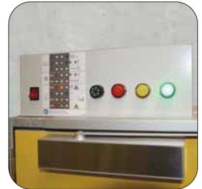
Steuereinheit mit Branddetektion
