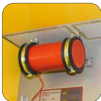
Aerosol-Löschgenerator
