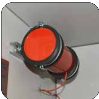
Aerosol-Löschgenerator
