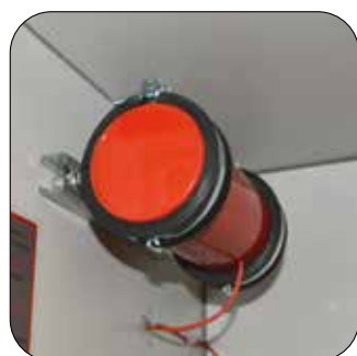
Aerosol-Löschgenerator
