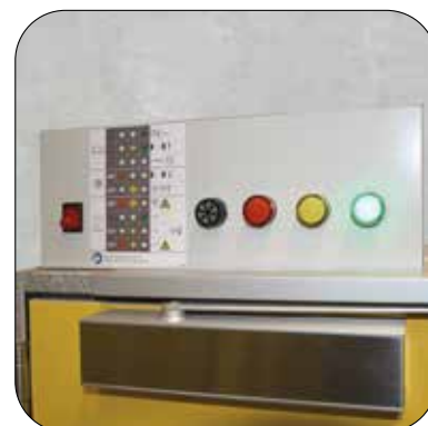
Steuereinheit mit Branddetektion
