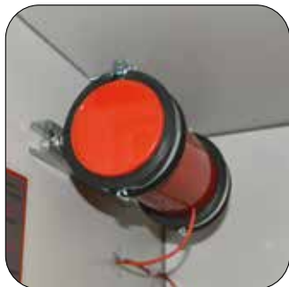
Aerosol-Löschgenerator
