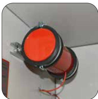
Aerosol-Löschgenerator
