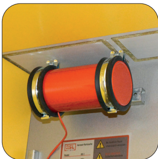
Aerosol-Löschgenerator
