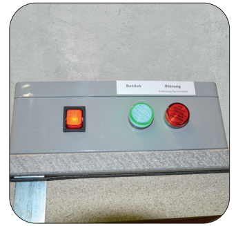
Steuereinheit mit Rauchdetektion
